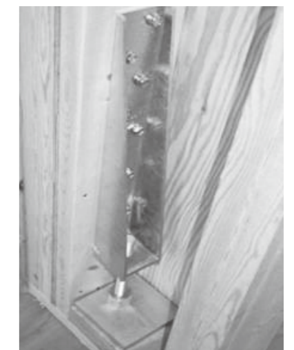
図6-5 高強度ホールダウン金物
